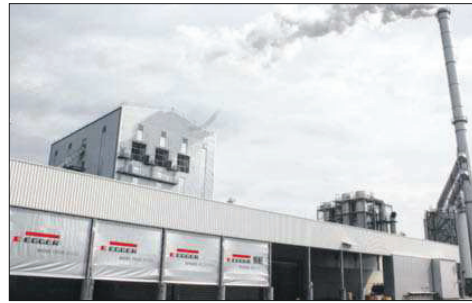
Einer der Initiatoren: die Egger Werke in Wismar.
